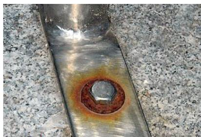
Fig. 12: Questo è un caso tipico di corrosione da contatto. Acciaio al carbonio zincato (rondella) e acciaio inox (vite e parte) sono stati utilizzati insieme. L'area superficiale del metallo più nobile, l'acciaio inox, è maggiore, provocando una forte corrosione della rondella.
